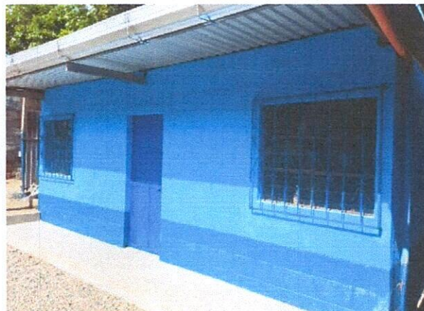
foto 2: Aula No. 2 ya pintada en su interior y exterior
