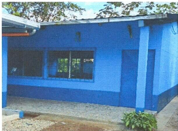
Foto1: Aula No. 1 Yapintada en su interior y exterior.
