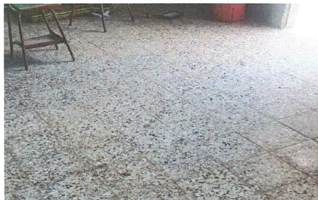
Foto 4: Piso de aula No. 2 (piso de granito instalado)
