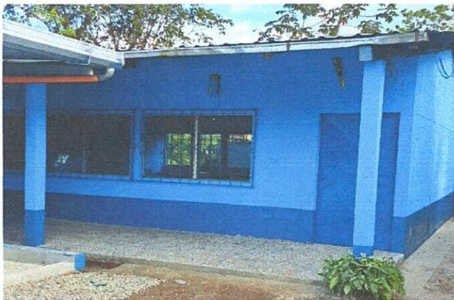
Foto1: Piso y puerta de aula No. 1 ya mejorada
