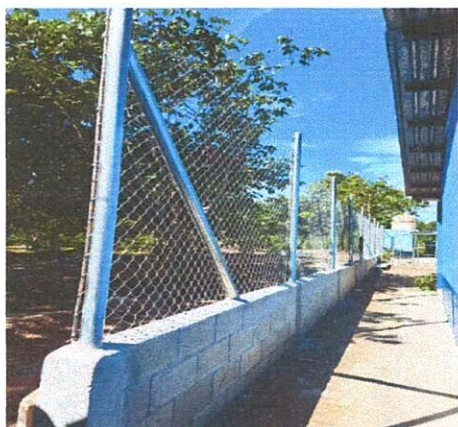
Foto 3: .Muro perimetralcon malla, block y tubos galvanizados
